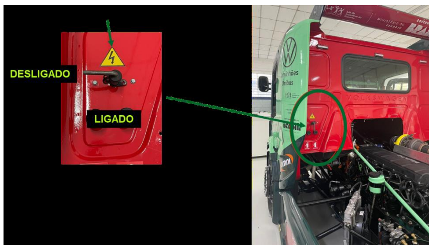
Chave de Corte Geral (Kill Switch) fora da cabine
